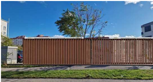
Batteriespeicher mit Holzverkleidung
